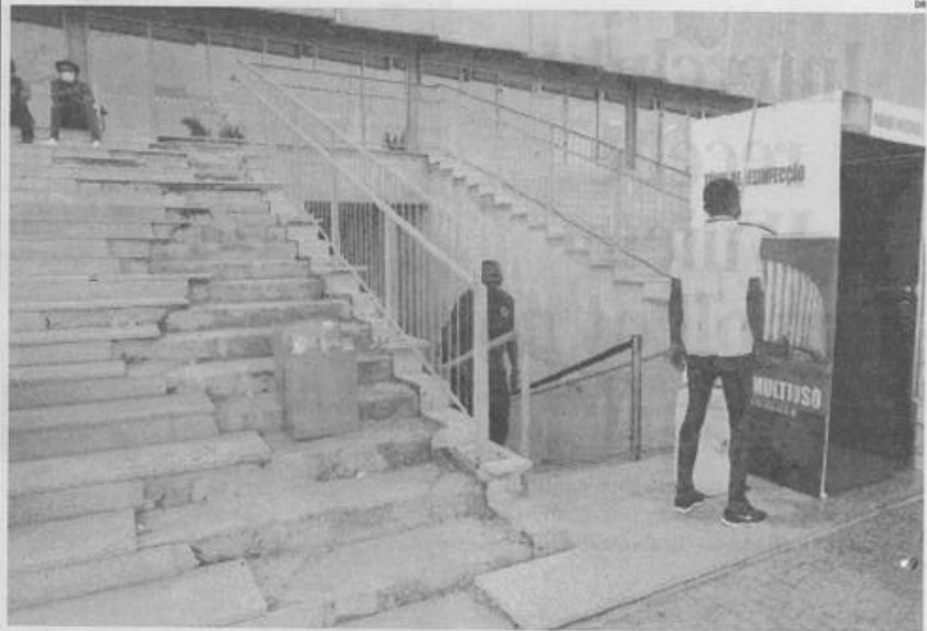
Degradação da infra-estrutura desportiva mereceu a intervenção rápida da empresa contratada pelo Ministério da Juventude e Desportos
